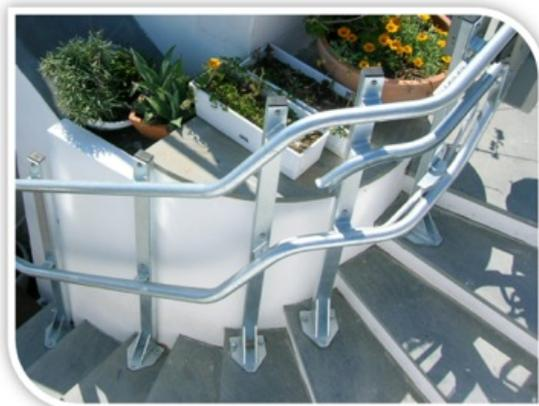
Fissaggio a gradino e zincatura a caldo
