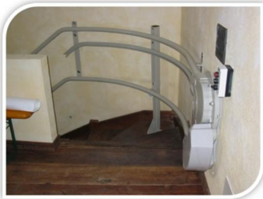
Curva esterna con fissaggio misto a muro e gradino
