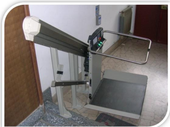
Fissaggio a gradino con pilastri autoportanti
